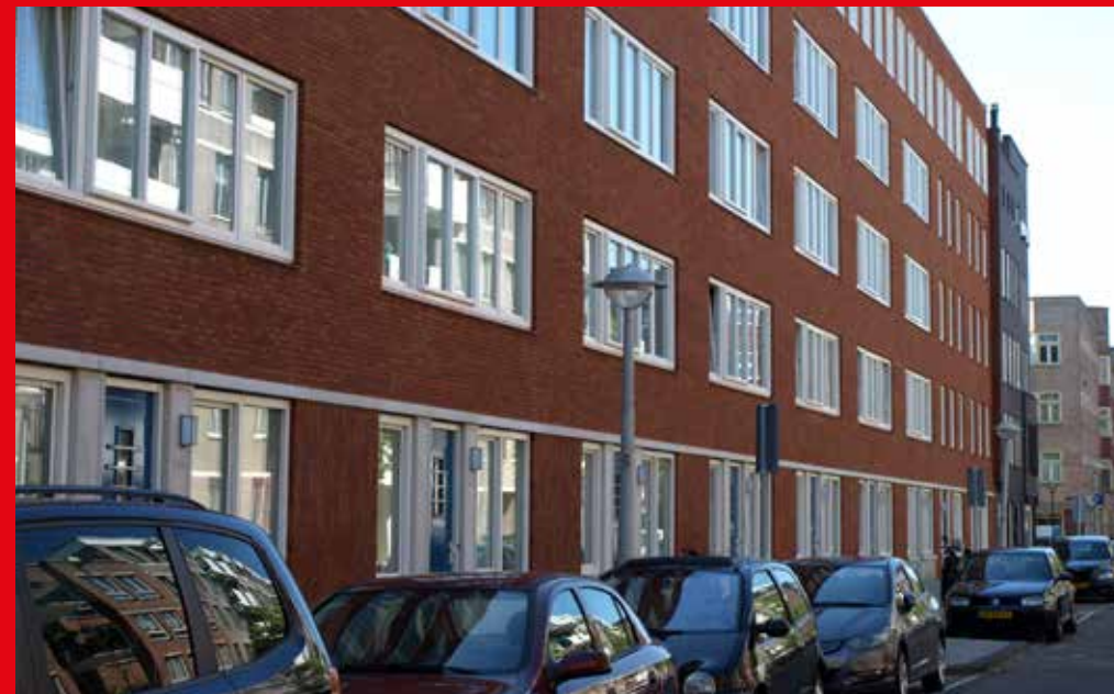
Afbeelding voorgevel Blok 3 Sumatraplantsoen.
