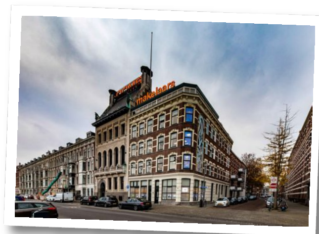
Maaskade 113, 3071 NJ Rotterdam
