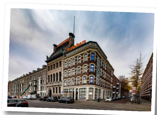
Maaskade 113, 3071 NJ Rotterdam
