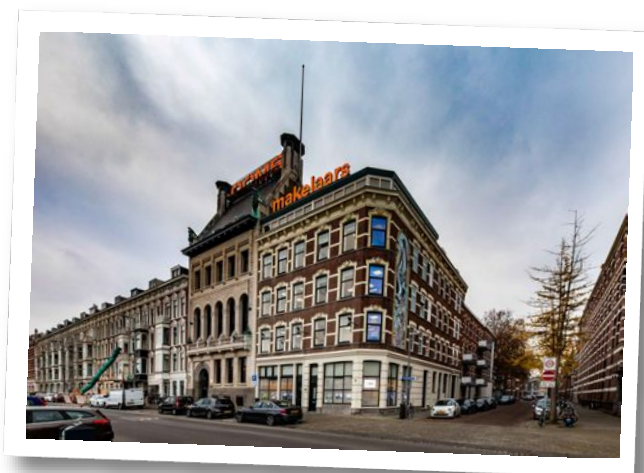
Maaskade 113, 3071 NJ Rotterdam
