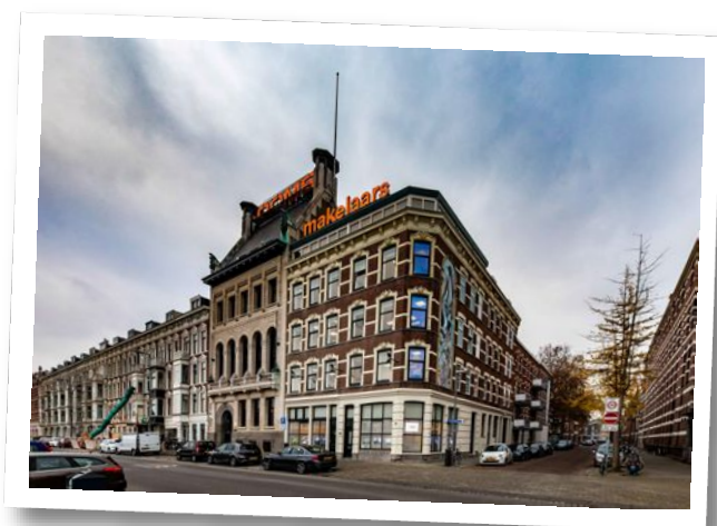
Maaskade 113, 3071 NJ Rotterdam
